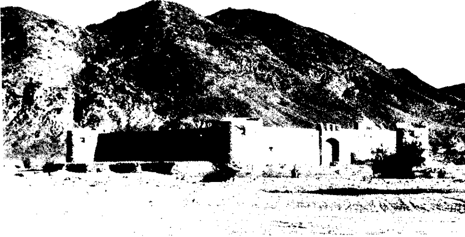
لوحة رقم ١ . منظر عام لقلعة الزريب بالوجه، تظهر فيه الواجهة الشمالية للقلعة وواجهة المدخل .
